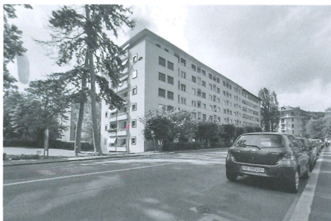
Das Haus aus den 1950er-Jahren in Genf vor der Aufstockung | L'immeuble des années 1950 à Genève avant la surélévation
