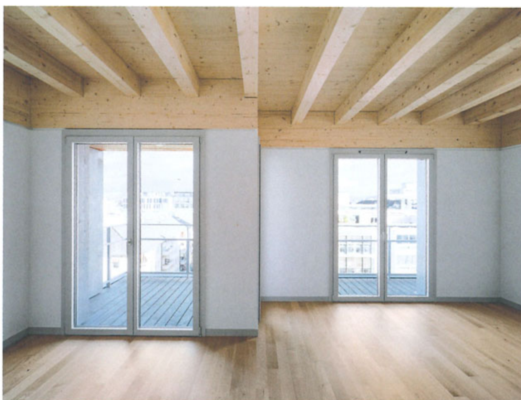
Die Holzdecke der Aufstockung | Plafond en bois de la surélévation
