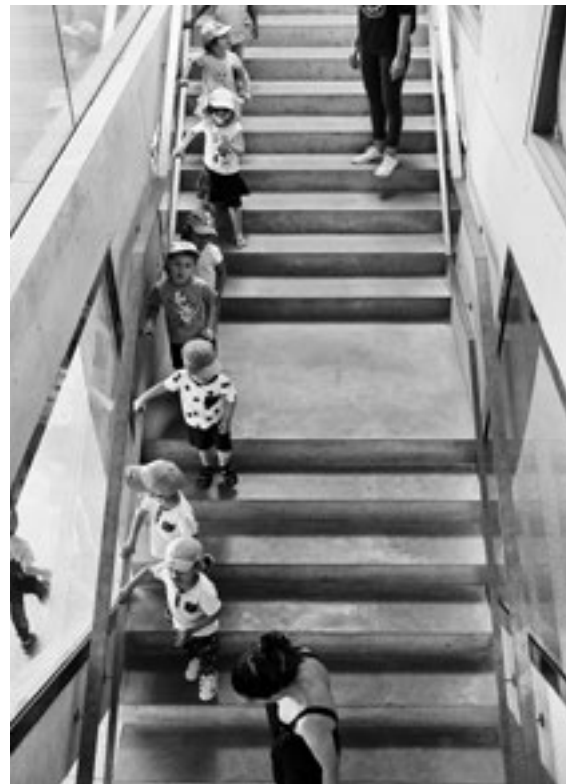
Détail de l'escalier central
