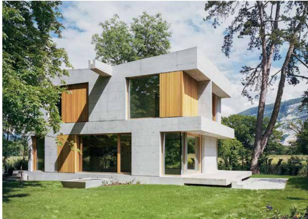
oben: Die Sichtbetonkonstruktion beruht auf der Stapelung zweier «Tische». Fensterstürze und Geschossplatten sind aus einem Guss betonierte.
