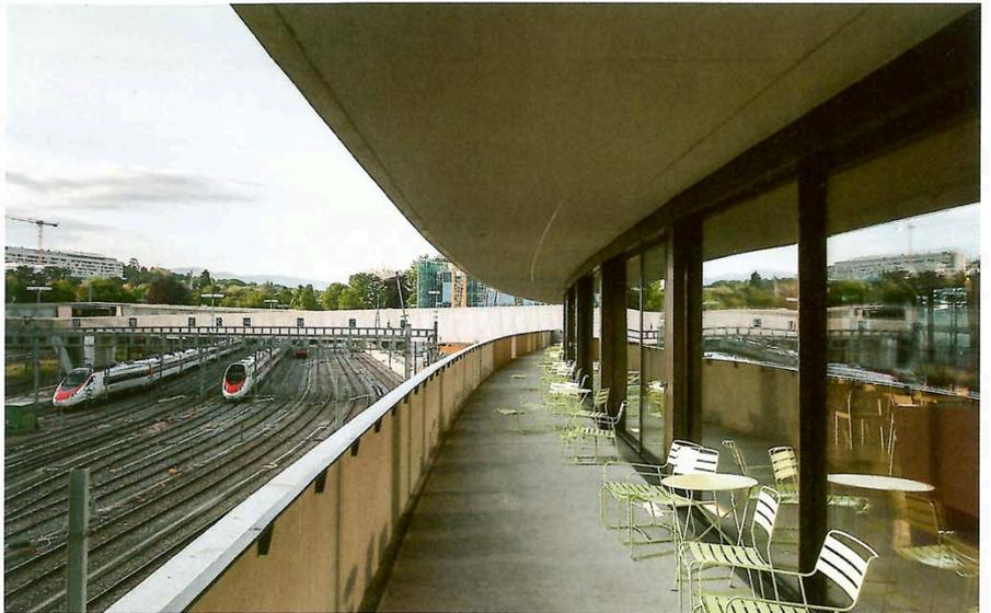
Die Laubengänge sind der halb öffentliche Bereich der Studentenwohnungen. Die Balustraden absorbieren den Bahnlärm. Weiter oben übernimmt die Decke diese Funktion. Das Langhaus ist auf ein viergeschossiges Parking aufgesetzt. Dessen Dach ist zugleich Terrasse und öffentliche Durchgangszone.
