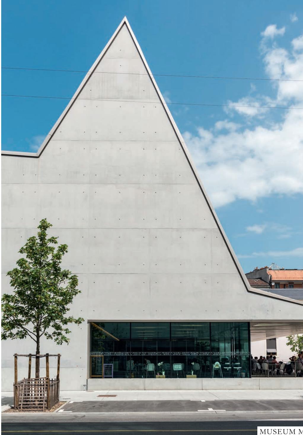
Das markante Musée d'ethnographie de Genève, entworfen von Graber Pulver Architekten AG, wurde 2014 fertiggestellt.
