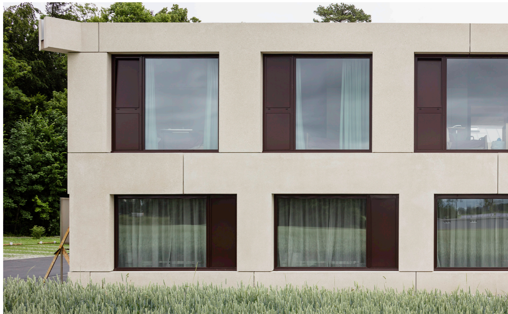
Die grossen Fenster bieten schöne Ausblicke auf die ländliche Umgebung beziehungsweise auf das Dorf.
