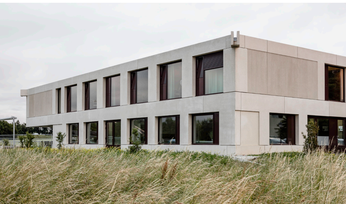
Die Gebäudehülle besteht aus vorgefertigten Stahlbetonelementen.
