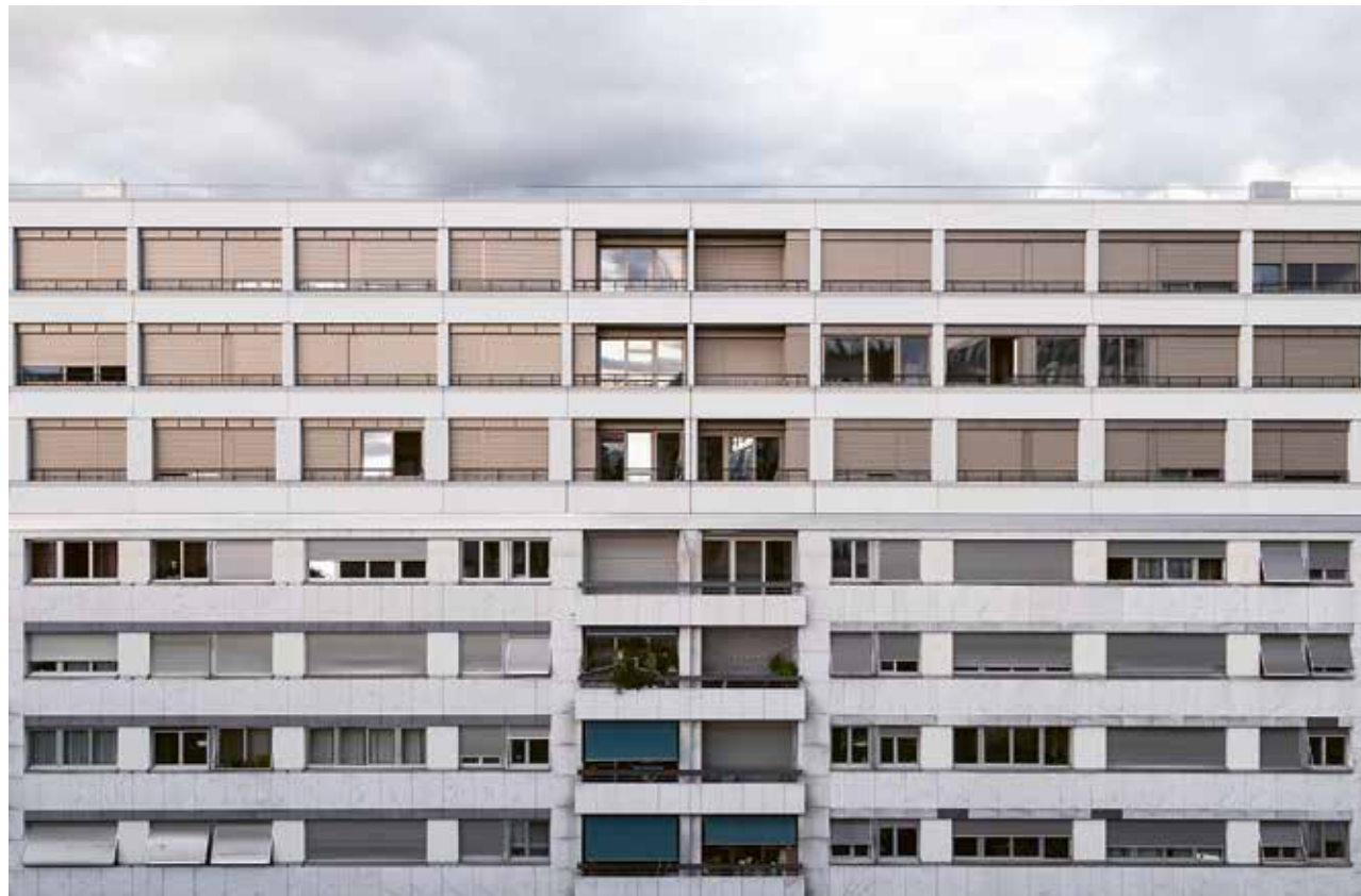
Mit der Aufstockung reagierte das Architekturbüro auf den Bestand. Der Rhythmus von Wandflächen und Öffnungen wird aufgegriffen, ist aber filigraner ausformuliert.
